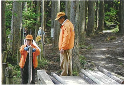
歩道整備中の様子
